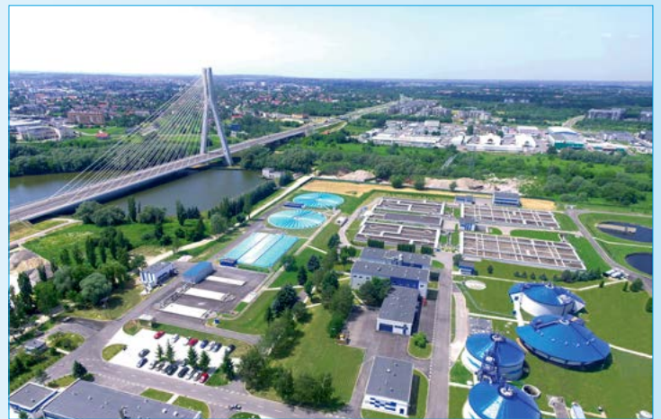
Oczyszczalnia Ścieków MPWiK Rzeszów z lotu ptaka
